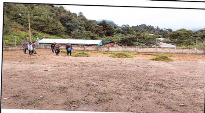
Foto 4: Aplanando la superficie para la sustitución de la losa del patio del establecimiento
