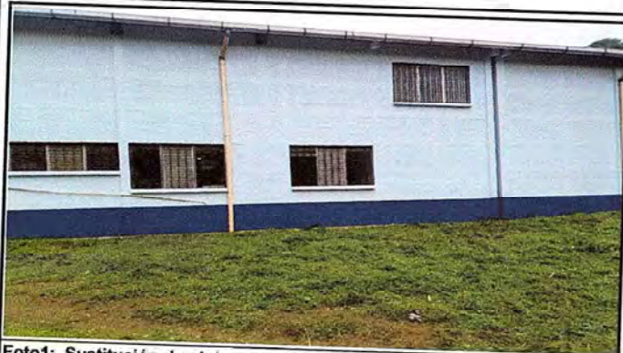
Foto 1: Sustitución de pintura en la parte lateral del establecimiento
