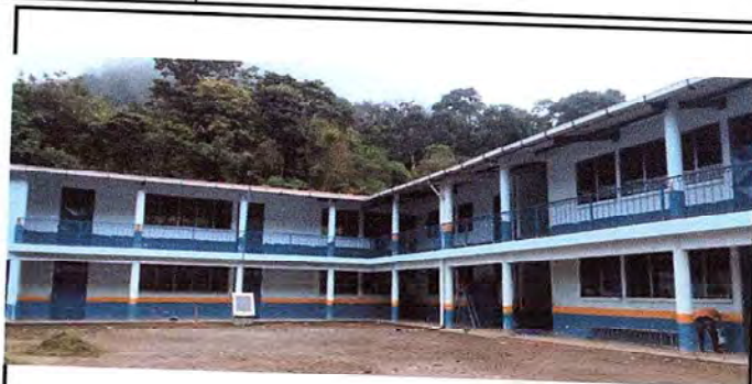
Foto 2: Sustitución de la Pintura en el segundo nivel del establecimiento.
