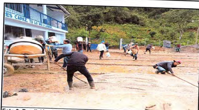
Foto 6: Fundición de la losa del patio del establecimiento
